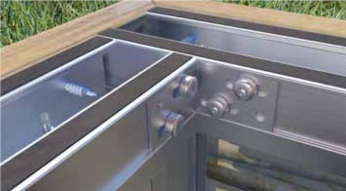
**12** Die Terrassendielen werden parallel zur Hausfassade verlegt. Begonnen wird an der Hausfassade mit der ersten Diele. In unserem Beispiel haben wir eine sichtbare Befestigung gewählt und die Dielen mit der Eurotec Profilbohrschraube an den Alu-Systemprofilen EVO angeschraubt. Als Hilfsmittel empfehlen wir den Drill-Stop, die Distanzklotzchen und die Spannzwinde.
