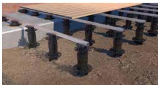
Erweiterung eines Terrassenfundaments mit dem Erdanker FLEXI.
