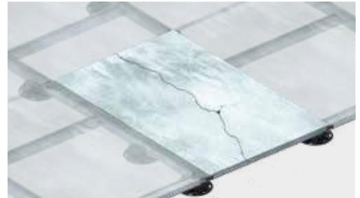
Erhöhte Bruchgefahr einzelner Platten aufgrund fehlender Stützprofile.
